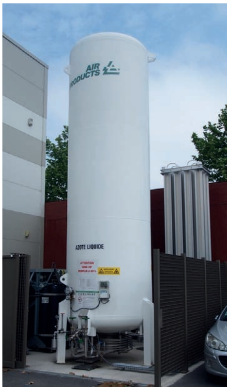
► Pour alimenter ses machines en azote, Technifab n'a pas hésité à investir dans une cuve azote Air Products de taille conséquente. À côté de la cuve, une alimentation en oxygène pour la découpe des aciers
