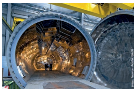
Cobroyage plastique sur l'autoclave de Nordenham – © Premium Aerotech GmbH
