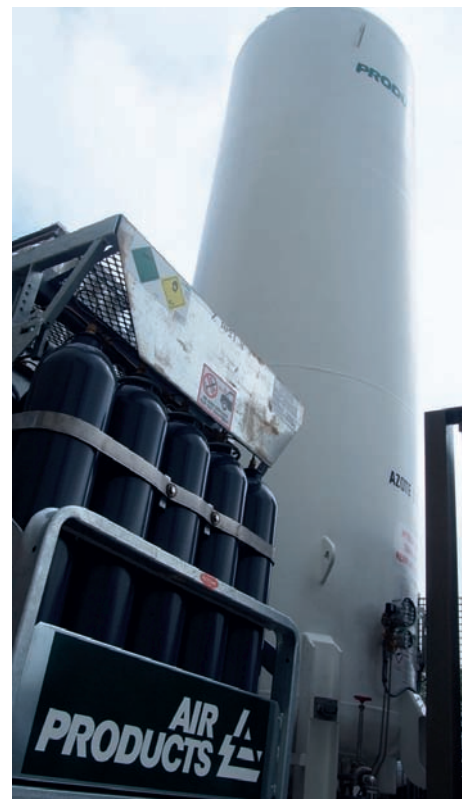
► Pour alimenter ses machines en azote, Technifab n'a pas hésité à investir dans une cuve azote Air Products de taille conséquente. À côté de la cuve, une alimentation en oxygène pour la découpe des aciers
