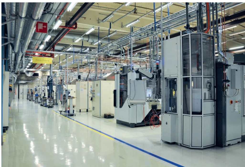
➤ La ligne de production sur le site de Gimo
