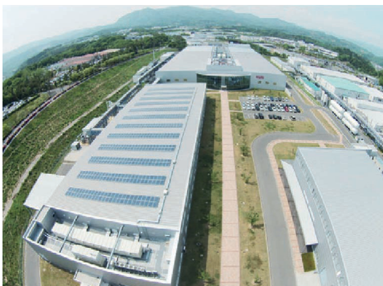
➤ Installation de panneaux solaires sur le toit du siège de Tungaloy au Japon.
