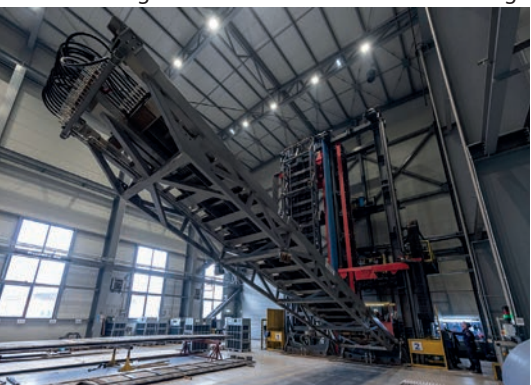
➤ Hissage des murs membranes sur la tour de soudage CMT
