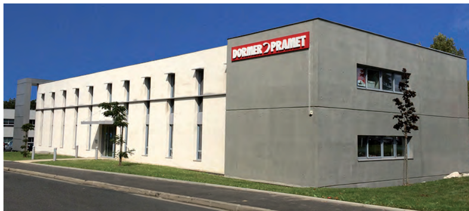
» Les nouveaux locaux de Dormer Pramet à Tours, berceau de la marque Safety
